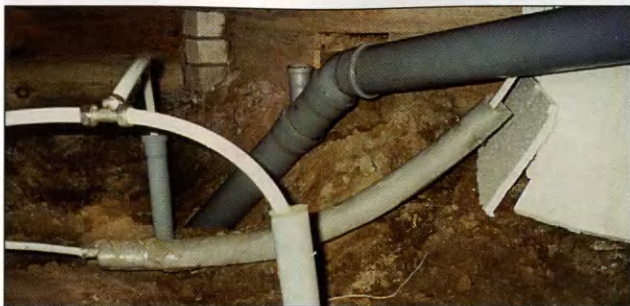
Канализационная труба в подполе
