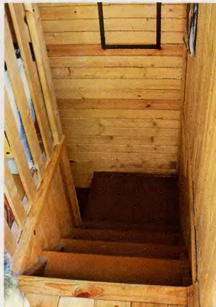
Пологая лестница в двумя поворотными площадками вдоль стены веранды облегчает подъем
