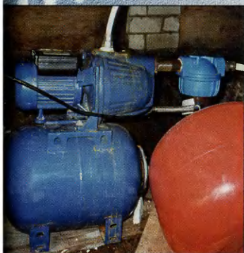
Насосная станция. Красный гидроаккумулятор установлен вместо штатного, вышедшего из строя
